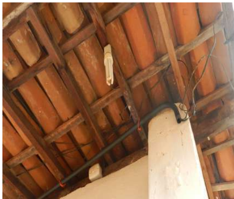
Fotos 13 e 14: instalações elétricas com fiações expostas
