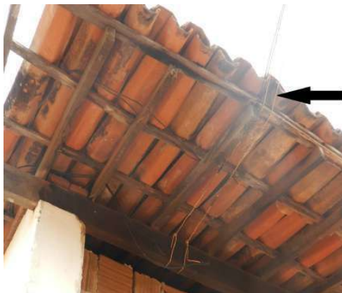
Fotos 15 e 16: Saída de fiação elétrica através da cobertura
