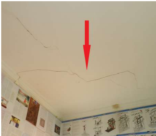
Fotos 8 e 9: Forros com rachaduras e sinais de infiltrações
